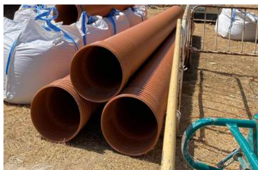
MANTENIMIENTO DE VÍAS PÚBLICAS
